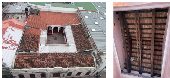
Figura 3: imágenes de cubierta
